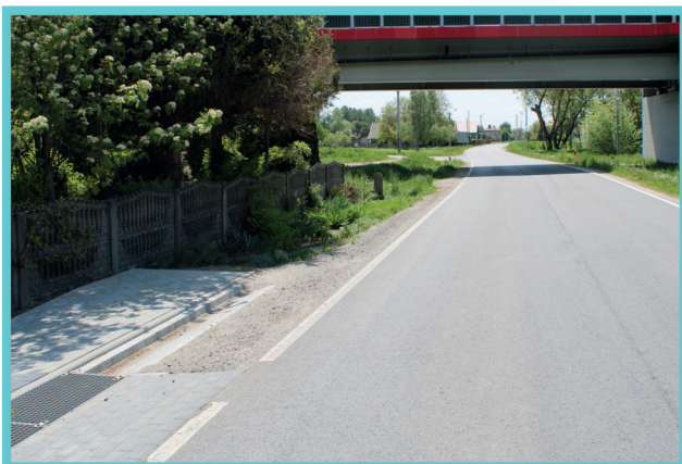
Przed budową chodnika w m. Sadkowa Góra
