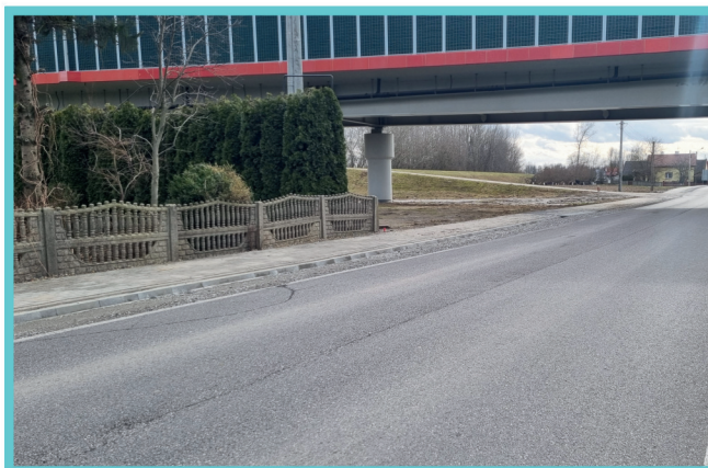
Po budowni chodnika w m. Sadkowa Góra
