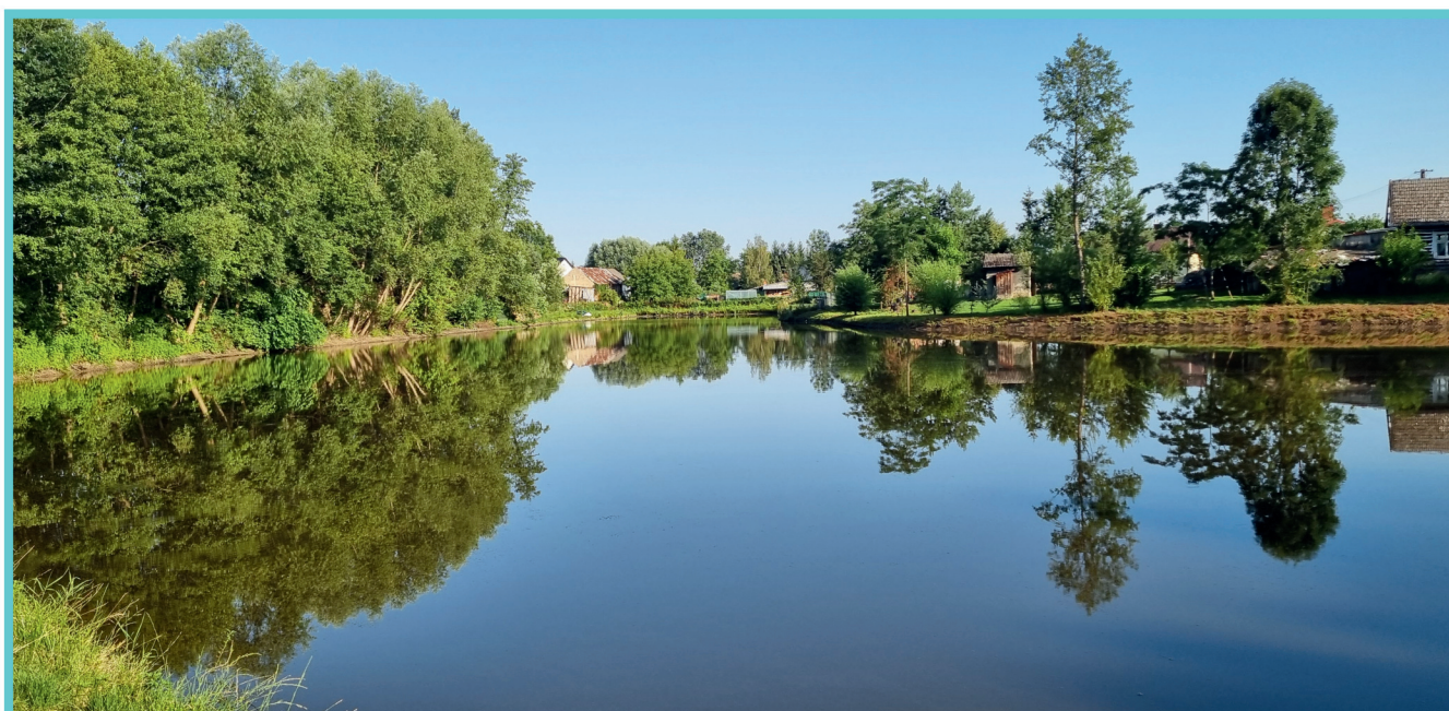
Zbiornik „Sicina” po renowacji
