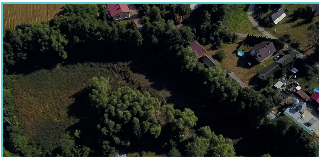
Zbiornik „Sicina” przed renowacją
