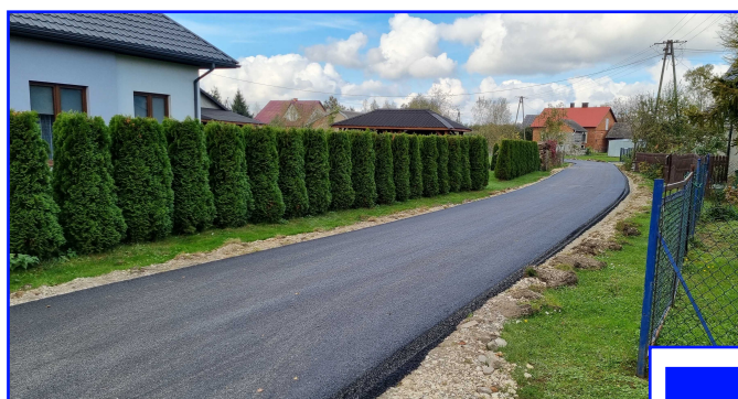
Przebudowa drogi w miejscowości Gliny Małe - 148 m
